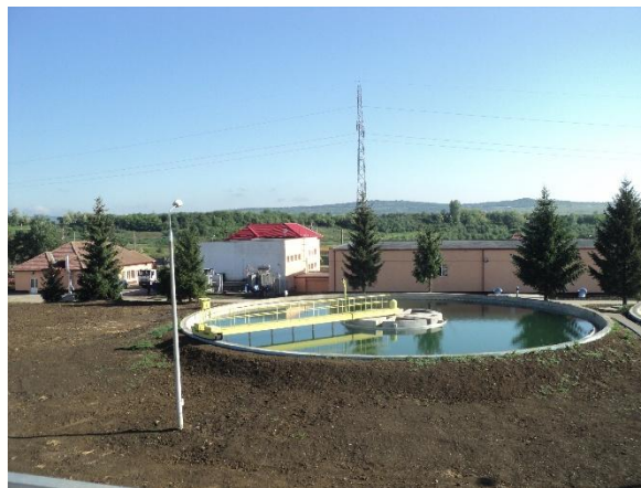
Stația de tratare a apei Vârșolț, modernizată
