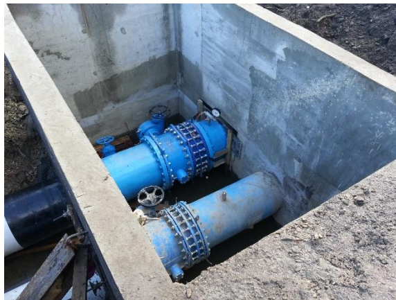
Reabilitarea aducțiunii Florești - Grigorescu
