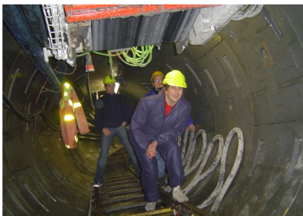
Canal colector Iașilor - Bd. N. Titulescu realizat prin săpătură în scut cu TBM similar Canalului Mânecii
