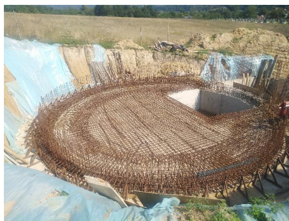
Armare Rezervor Gâlgău
